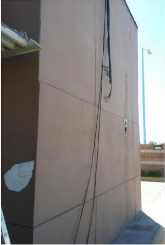
DETALLES EN MUROS EXTERIORES INSTALACIONES APARENTES, EMPLASTE BOTADOS, PINTURA EN HERRERIA CORROIDO.
