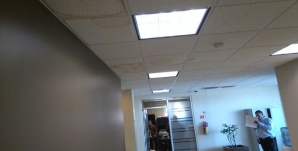
SITUACION INTERIOR DEL EDIFICIO POR FILTRACIONES DE AGUA.
