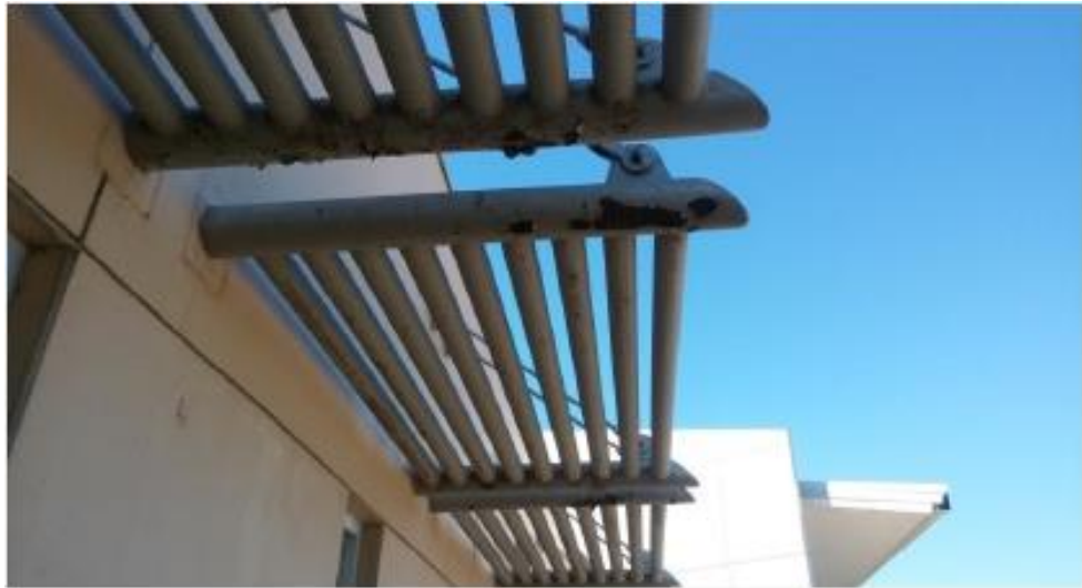
DETALLES EN MUROS EXTERIORES INSTALACIONES APARENTES, EMPLASTE BOTADOS, PINTURA EN HERRERIA CORROIDO.
